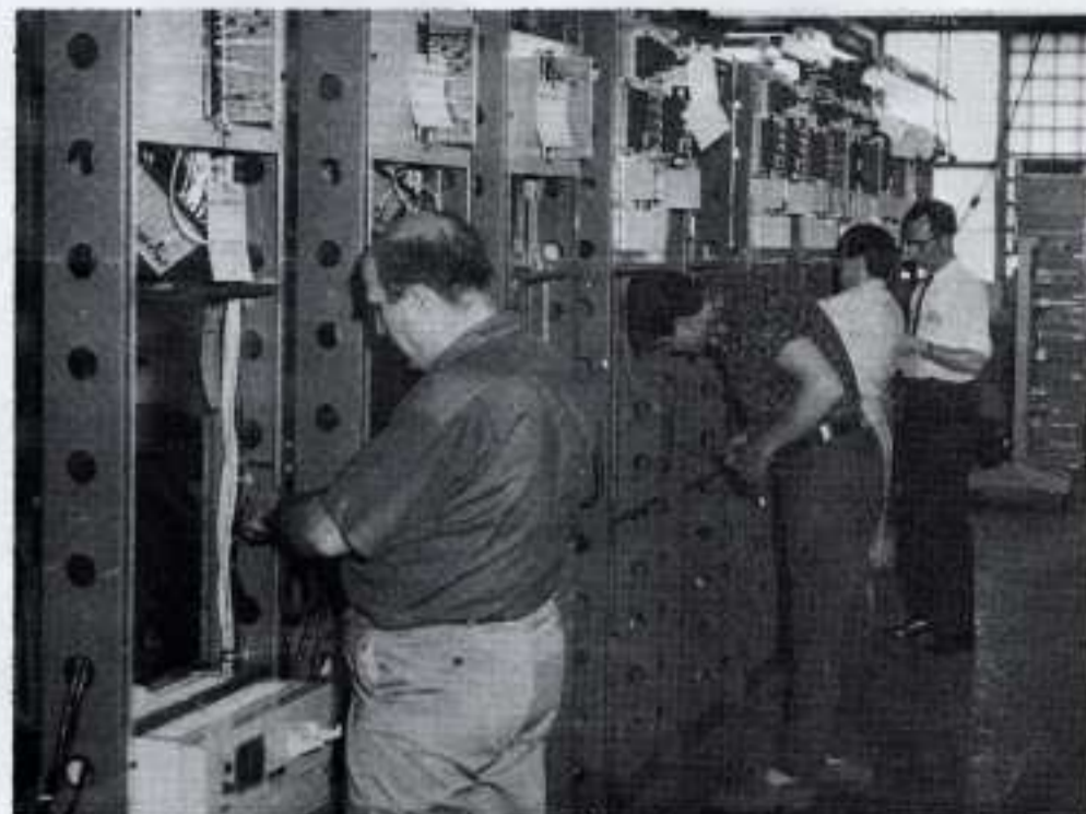
On assemble présentement à Montréal le support de la station pour le système de communications par micro-ondes du Mexique. Une fois l'assemblage terminé, on lui fera subir des tests finals avant la livraison. De gauche à droite, on peut apercevoir quelques uns des employés impliqués dans ce travail, Antonio Dimatteo, Raymond Lord, Thérèse Beausoleil et André Sarrazin.
